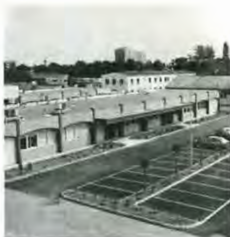
Le bâtiment «Jacques DELORT» nouveau Centre d'Essais
